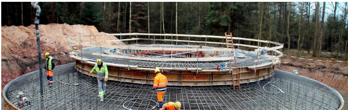
Bild 5: Fundament für eine Windkraftanlage.
